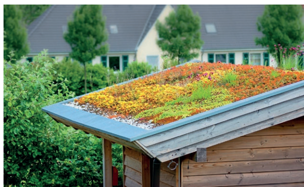
Abb.43 - Nebengebäude eignen sich gut für Gründächer
